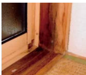
室内への雨漏り
