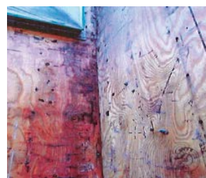
外壁内部の雨漏りの跡 (修補工事のため外壁をはがした状態)
